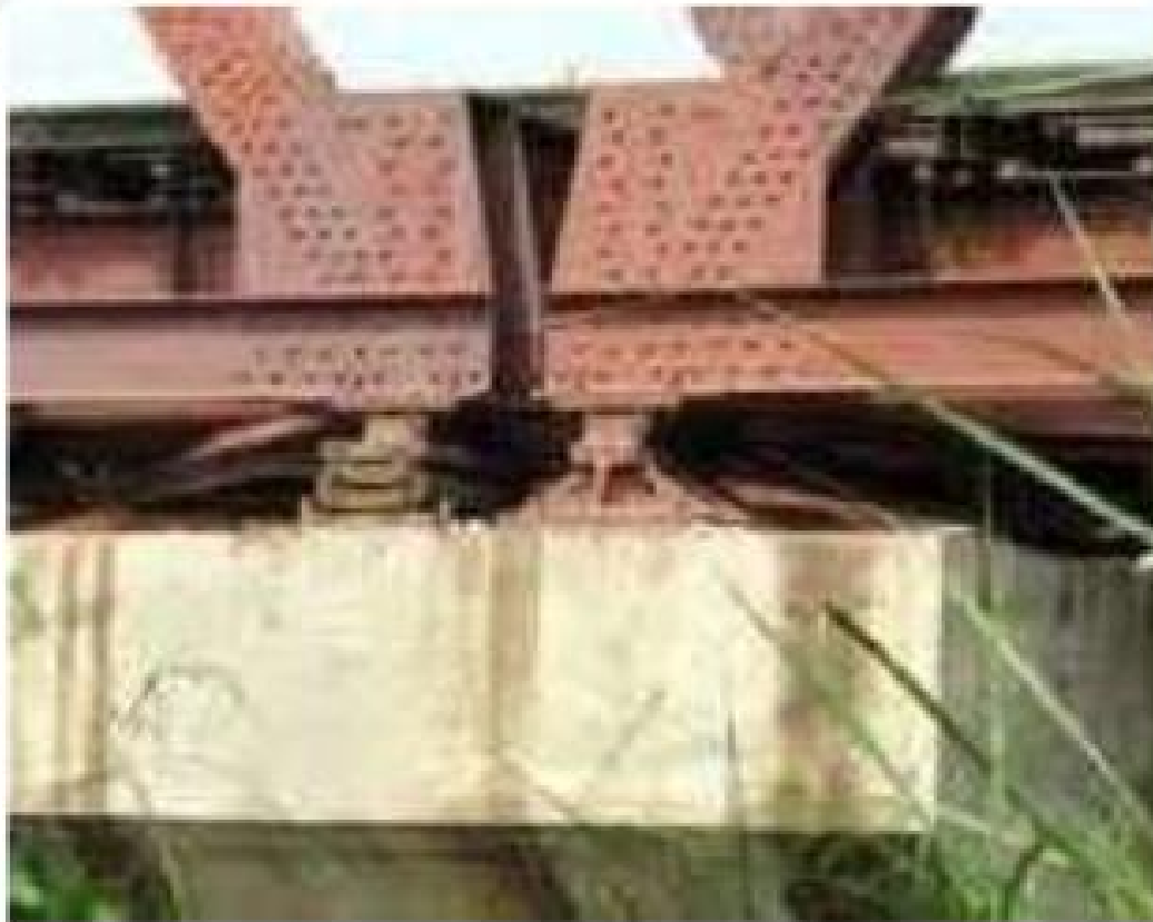
Penggolek pada jembatan keluli
